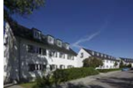
Siedlungs-Ensemble Regensburg Foto: Stefan Effenhauser
