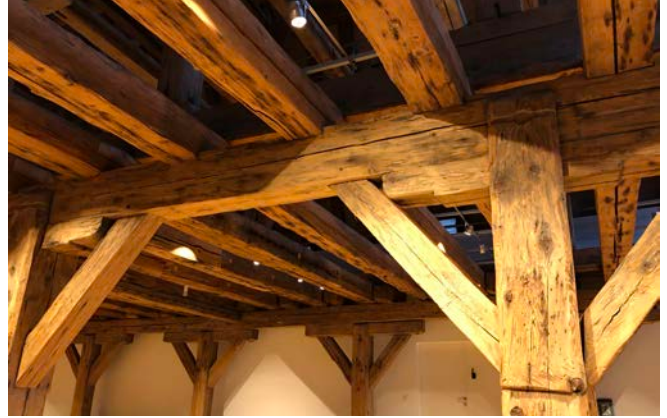
Dachkonstruktion Regensburger Salzstadel
