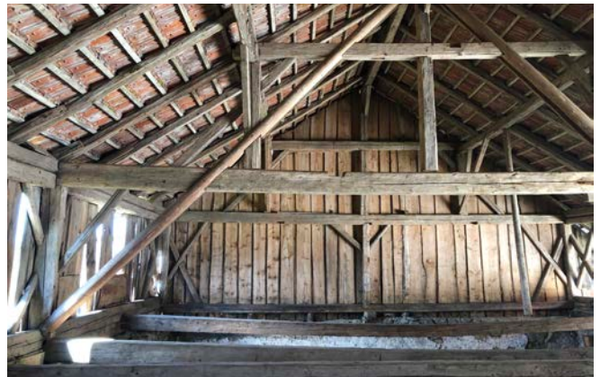
Dachstuhl einer Scheune, Niederbayern
