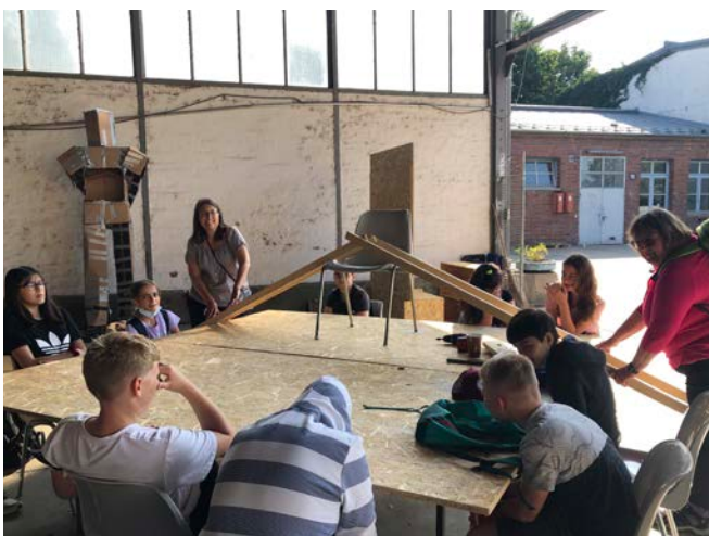
Ein stehender Stuhl stützt die Dachbalken
