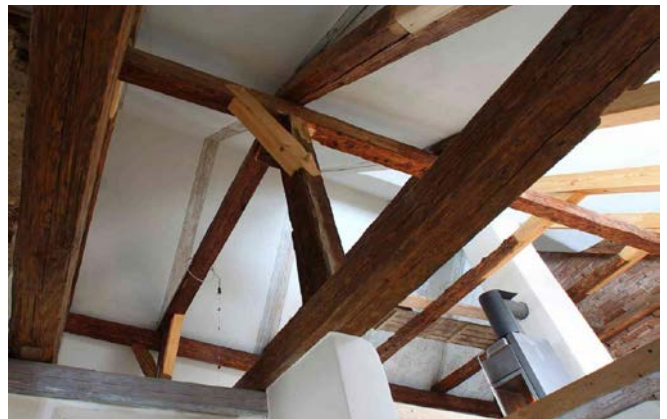
Denkmalgeschützter, sanierter Dachstuhl
